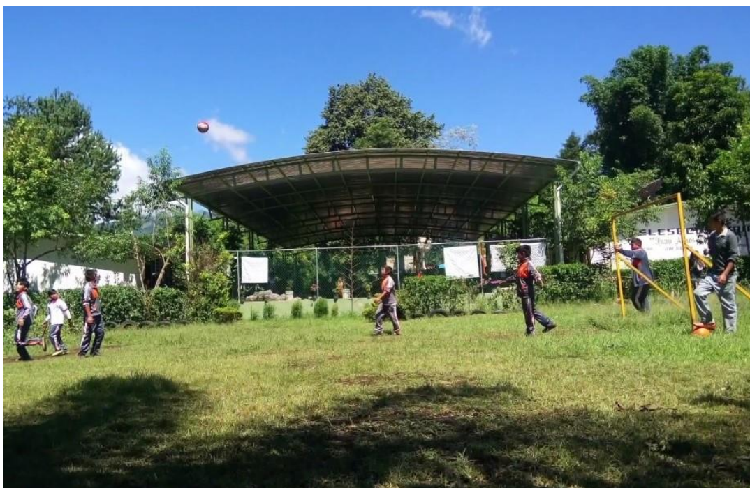
Imagen 5: Escuela telesecundaria Juan Amós Comenio Fotografía cortesía de Carlos Salvador Cárdenas
