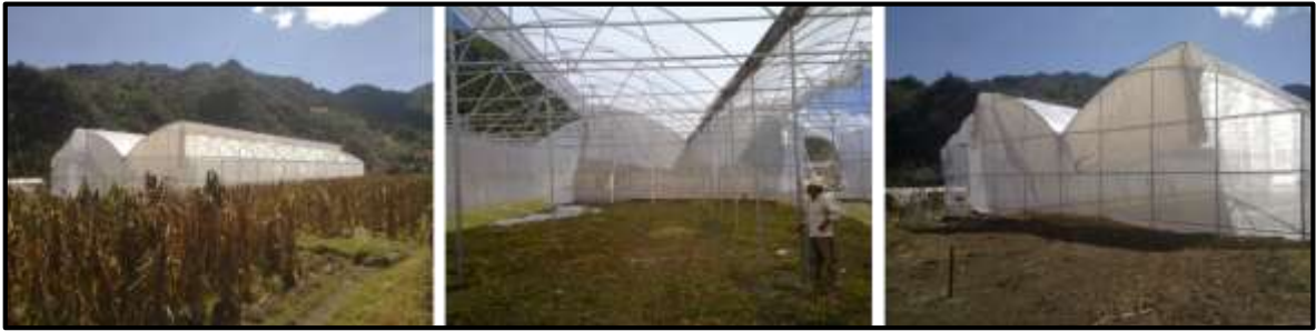
Figura 12. Infraestructura del invernadero tipo túnel con ventana cenital.
