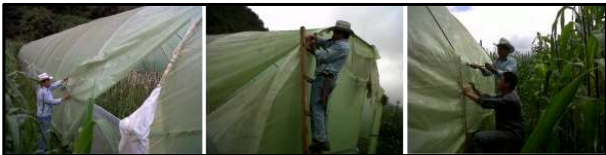
Figura 10. Rehabilitación del primer invernadero.
