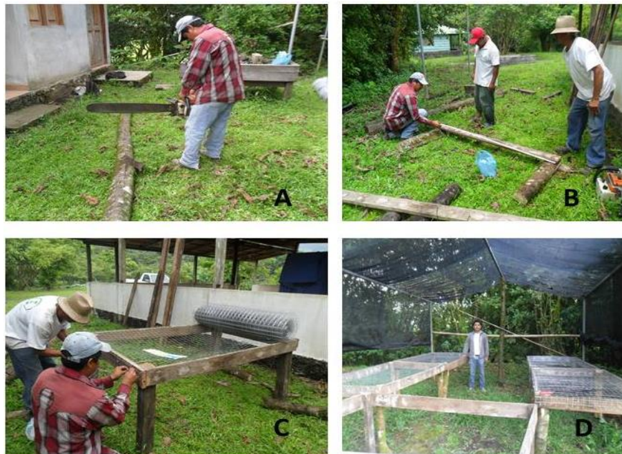
Fig. 20. A) Corte de troncos (80 cm) para las patas de las mesas; B) Unión de las maderas a los troncos para formar el marco de las mesas; C) Colocación de la malla de acero a la estructura de la mesa y D) Mesas terminadas dentro del vivero rústico.
