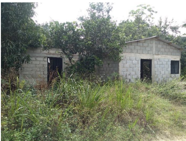
Ilustración 6. Viviendas deshabitadas en Miguel Hidalgo II. Noviembre, 2020, autoría propia.
