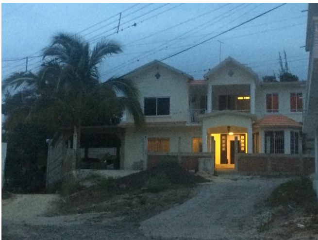
Figura 13 Vivienda en la Localidad de Los Otates
