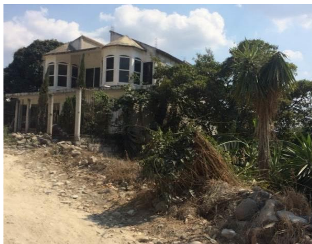
Figura 12 Vivienda en la Localidad de Coyolillo
