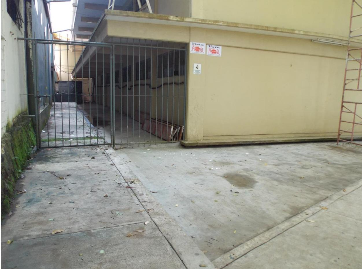
Se colocó concreto hidráulico en el pasillo trasero del edificio C, para evitar que se siguiera infiltrando el agua que causaba humedad en salones y cubículos.
