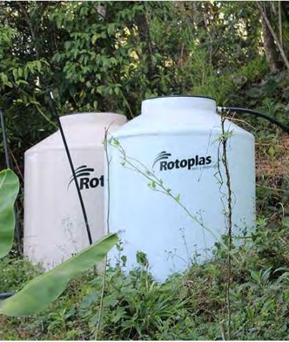
Instalación de tinacos
