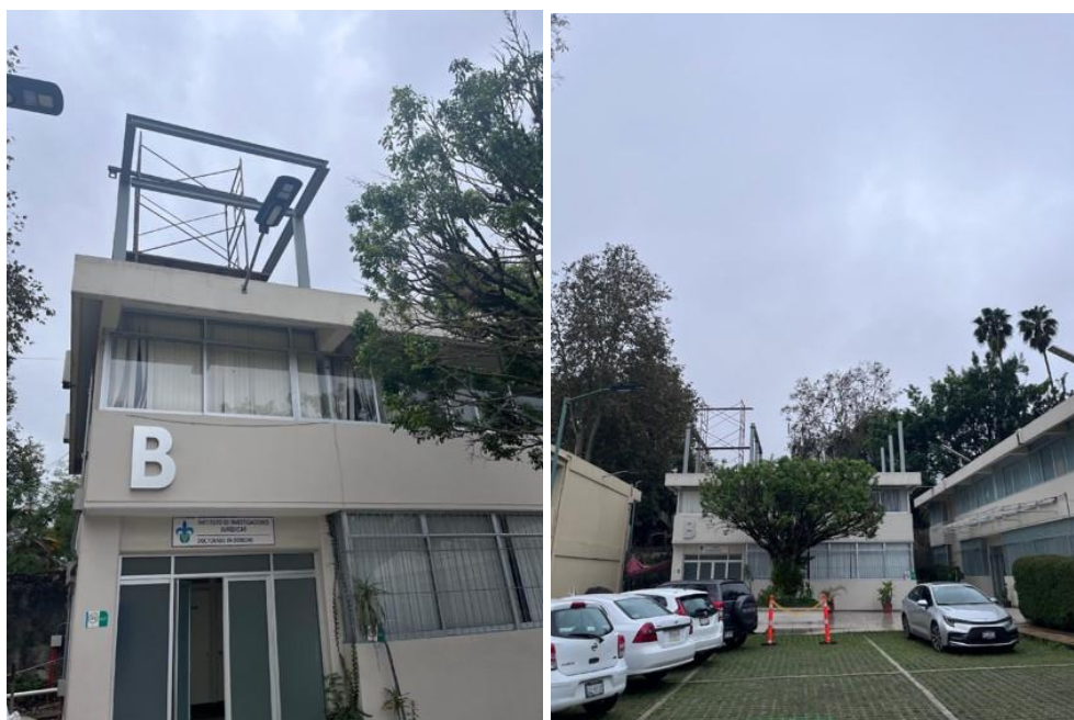
Imagen 20. Ampliación del Edificio “B”
