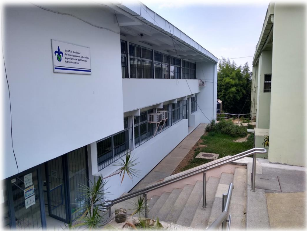
Fachada lateral del IIESCA
