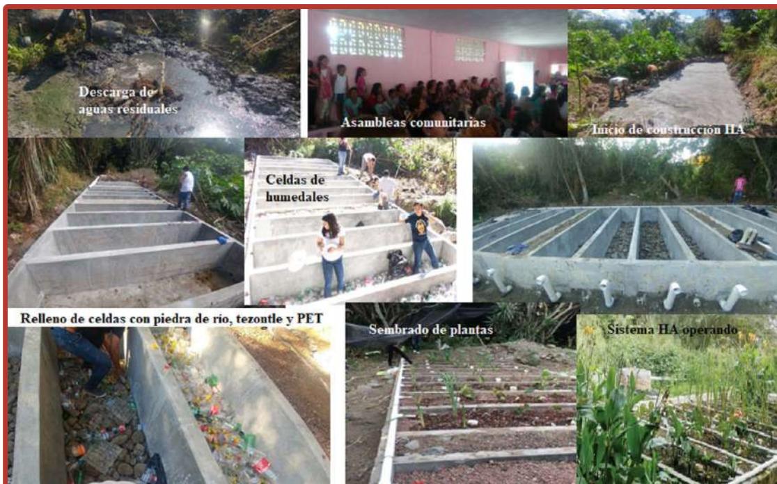
Imagen 2. Construcción del sistema de humedales.
