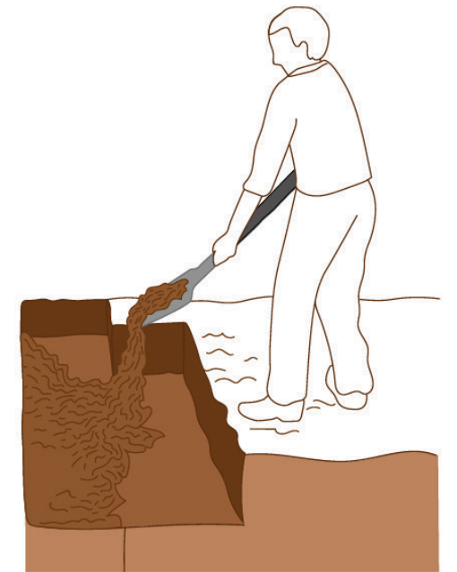
6 Escarba otra zanja con las mismas medidas. Usa la tierra que sacas de aquí para tapar la primera zanja.
