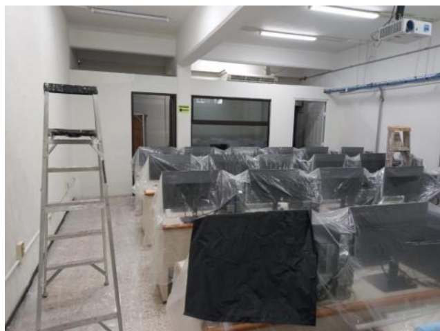
Figura 50. Remodelación de Aula de Cómputo Referencia: (Propia)
