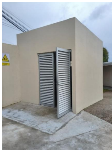
Figura 52. Contenedor de basura Referencia: (Propia)
