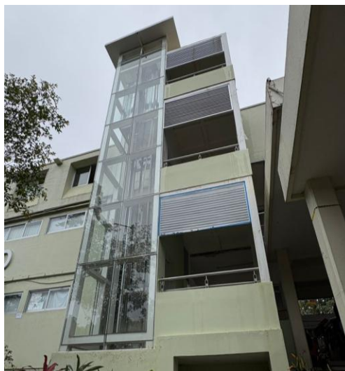
Figura 9. Construcción de Elevador para mejorar el acceso a instalaciones de la unidad Referencia: (Propia)
