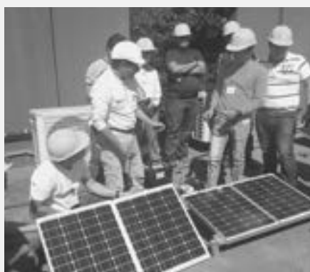
Egresado: Ing. Arturo García Pérez Capacitación sobre instalación de celdas solares Empresa Impulsomex Cuernavaca Morelos
