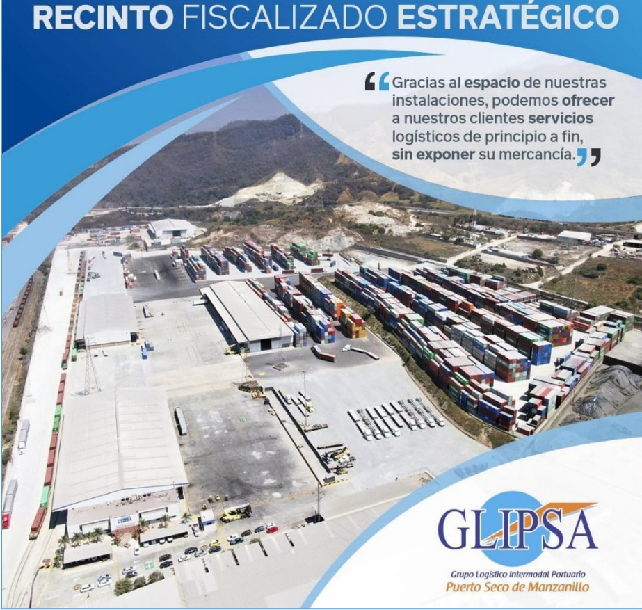
Figura 39. Parte del recinto fiscalizado estratégico de Manzanillo Referencia: tomado de GLIPSA, 2021
