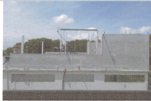
F2: Fotografía tomada del segundo nivel del Edificio "C" donde se observa parte de los muros de la fachada.
