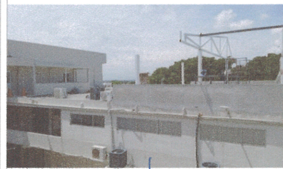
F5: Fotografía tomada del segundo nivel del Edificio "C" donde se observa el área en construcción, así como el pasillo de unión entre edificios.
