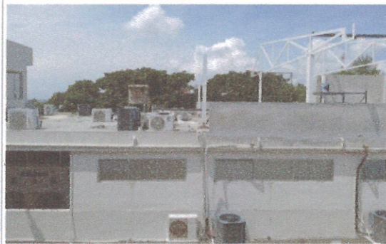
F3: Fotografía tomada del segundo nivel del Edificio "C" donde se observa la superficie de la azotea donde se están levantando los muros.
