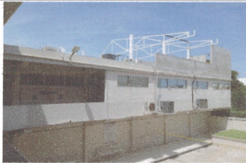
F1: Fotografía tomada del primer nivel del Edificio "C" donde se observa la fachada del edificio con los muretes ya levantados.
