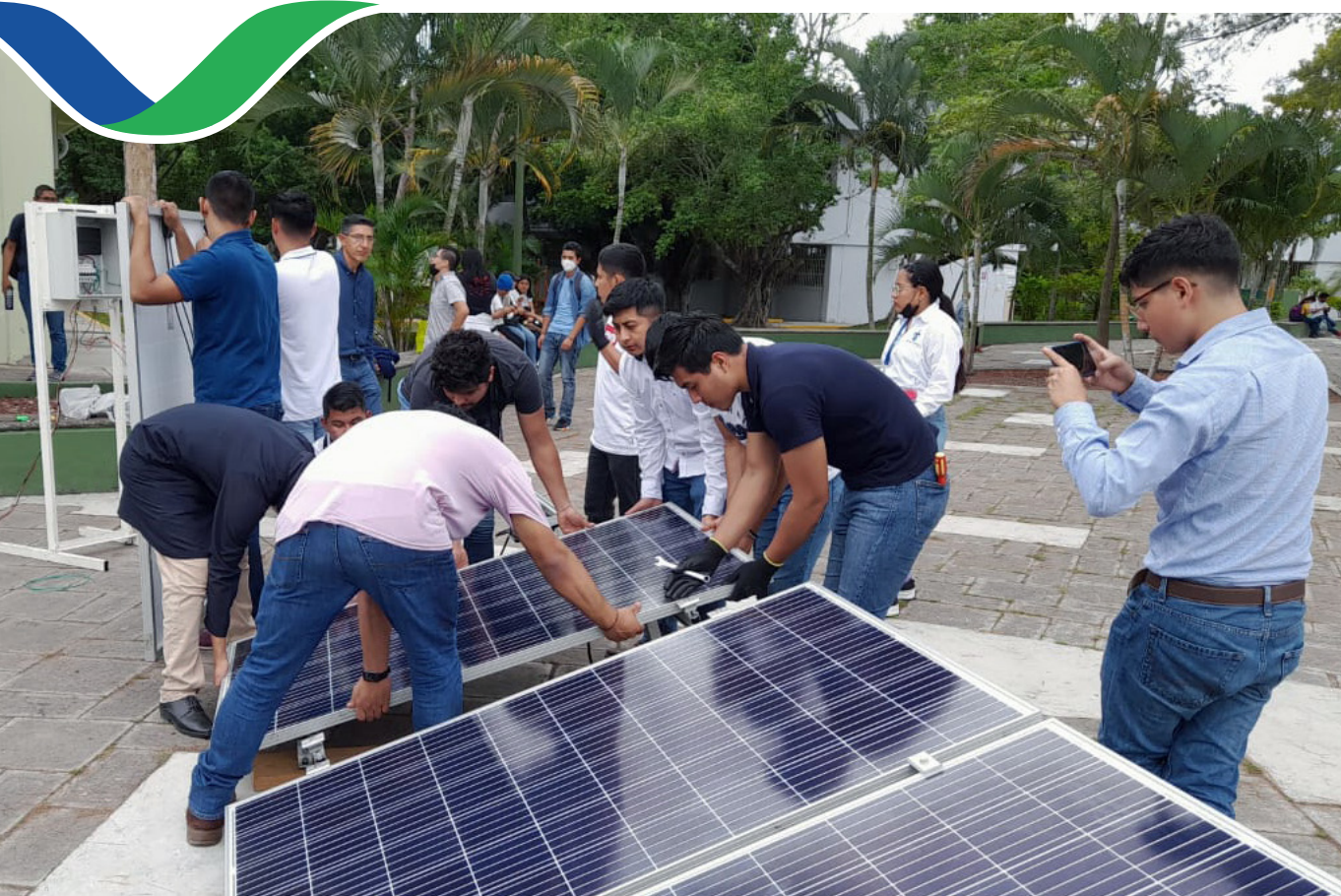
Alumna y alumnos de las ingenierías: Eléctrica, Mecánica Eléctrica, Mecánica e Industrial en el curso-taller “Especializado en Instalación de Paneles Solares con Microinversores Enphase, APSystems, Hoymiles”. Región Poza Rica-Tuxpan. Foto: Vice-Rectoría Poza Rica-Tuxpan.
