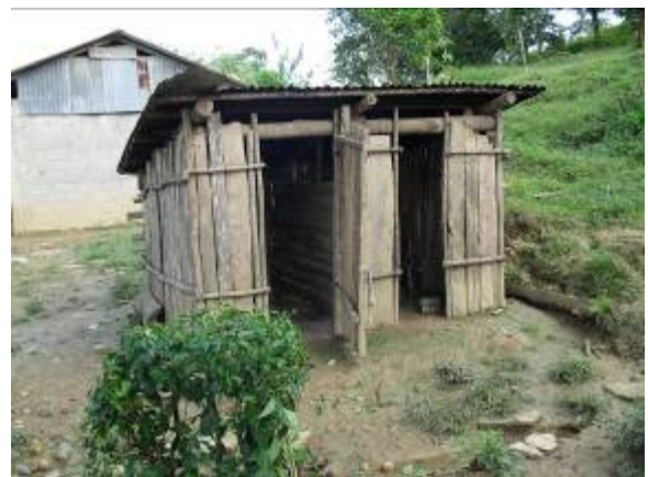
Letrinas secas en la comunidad Progreso.
