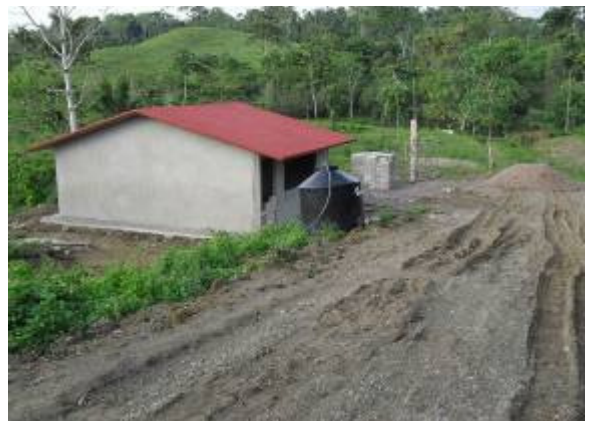
Instalaciones de la Telesecundaria de El Progreso, en proceso de construcción.
