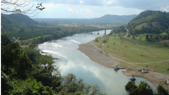
El río y el puente El Remolino.
