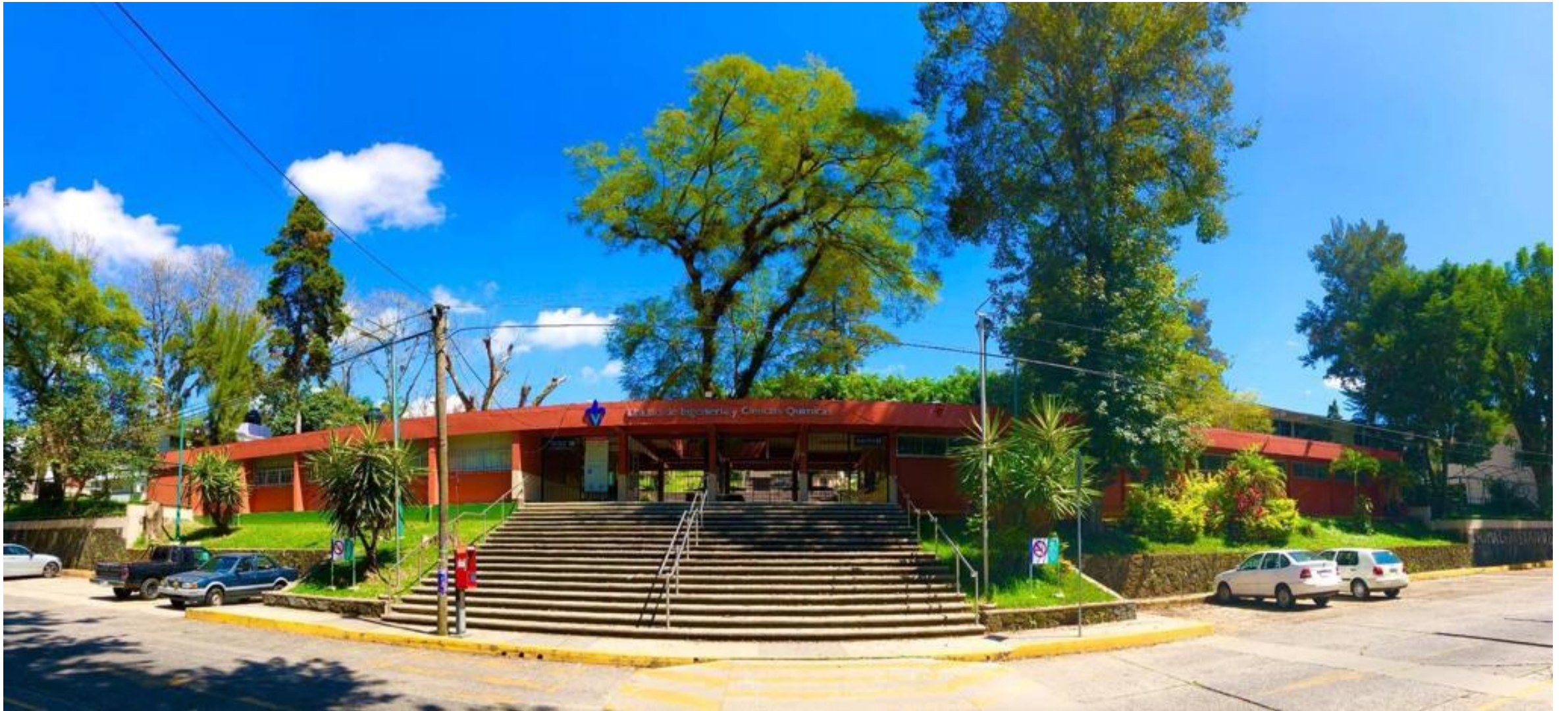
Acceso principal a la Unidad de Ingeniería y Ciencias Químicas
