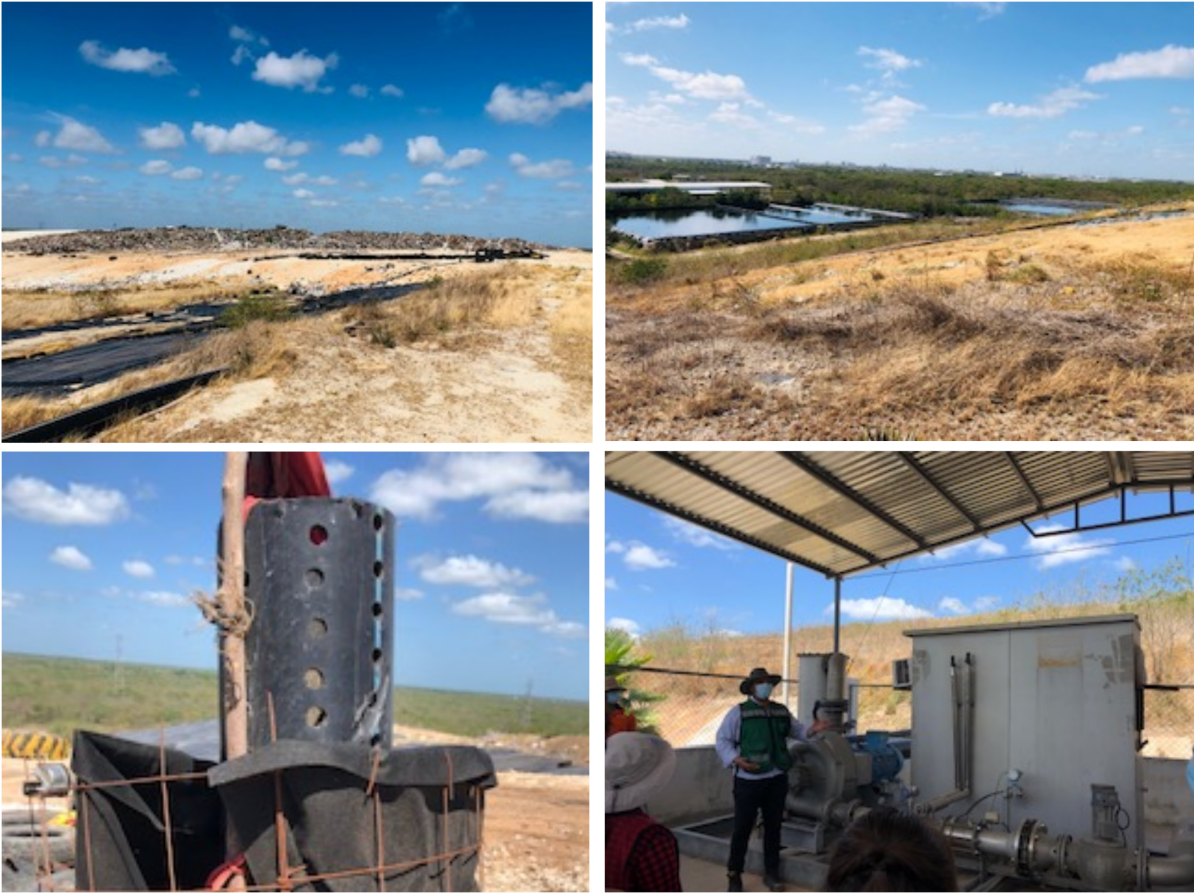
Vista de la celda diaria y altura del relleno sanitario de la ciudad de Mérida, Yucatán (Valladares G. G. 2022).
