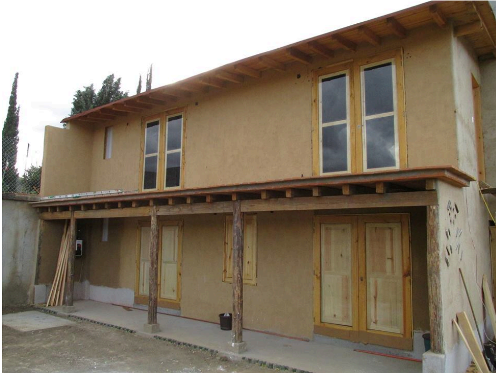
Casa de bahareque construida por EcoConstructores Oaxaca
