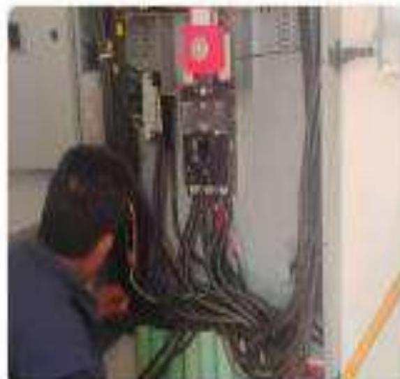
SUMINISTRO Y COLOCACIÓN DE CAJA TRIFASICA METÁLICA DE 37.5 CM DE ANCHO X 28.0 CM DE ALTO X 25 CM DE FONDO, PARA ALOJAR TCS TIPO DONA DE CFE, EN TRANSFORMADOR TRIFASICO TIPO PEDESTAL CAPACIDAD 150 KVA, INCLUYE: COLOCACIÓN DE MANGA TERMOCONTRACTIL PARA CABLE 1/0, DESCONEXIÓN Y CONEXIÓN DE TERMINALES Y TCS, FIJACIÓN, MATERIALES, MANO DE OBRA ESPECIALIZADA, HERRAMIENTA, LIMPIEZA DEL ÁREA Y TODO LO NECESARIO PARA SU CORRECTA EJECUCIÓN
