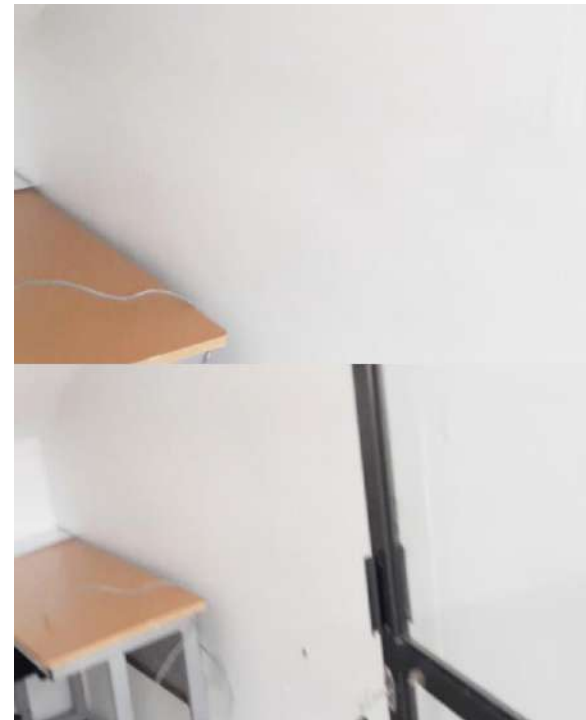
División de espacio de oficina
