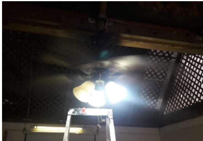
Reparación de lampara con ventilador del salón de usos múltiples.
