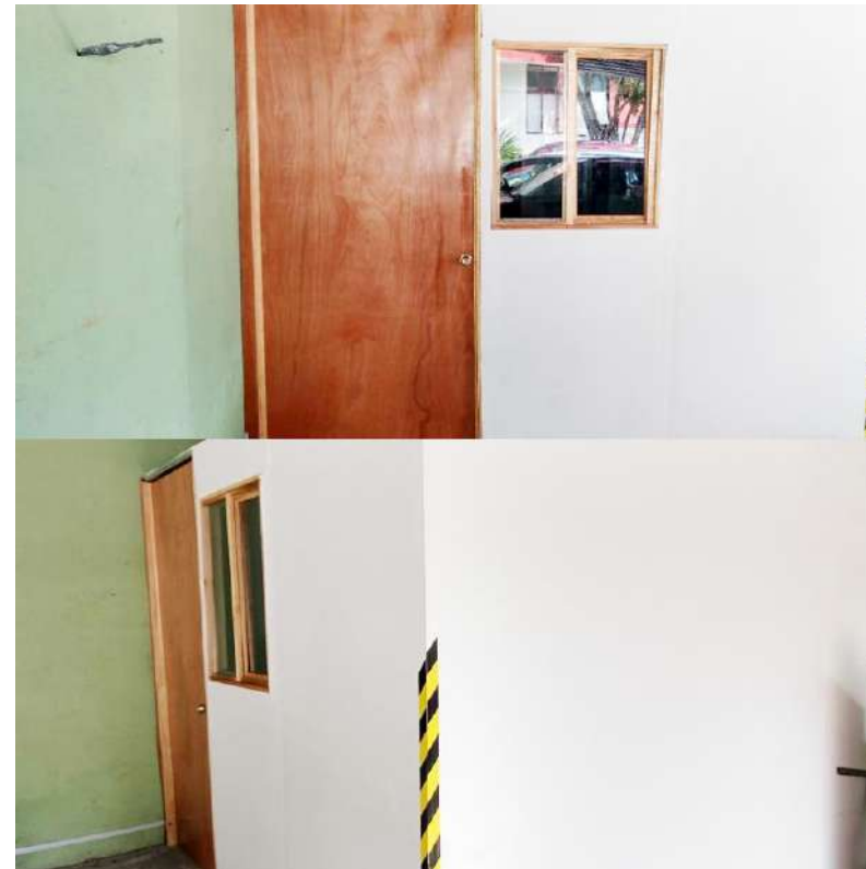
Construcción de cuarto de refrigeración
