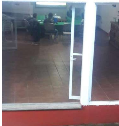
Pintado de fachada del salón .
