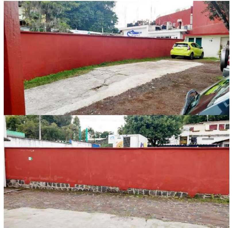
Mantenimiento de pintura en barda, estacionamiento
