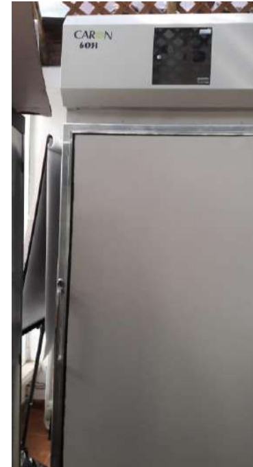
Instalación eléctrica para germinadora colocada en el salón de usos múltiples del orquidario.
