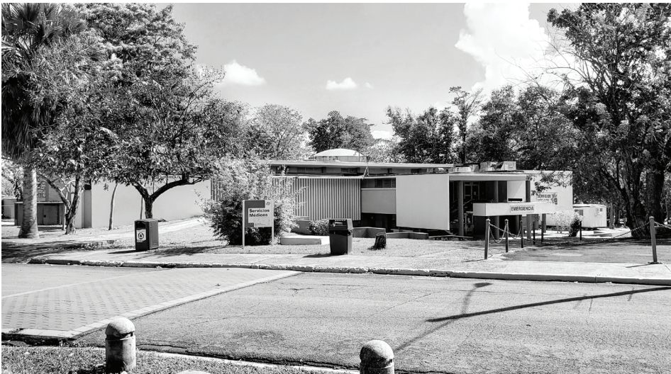
Foto 8. Vista desde el Edificio de Pedagogía. Servicios Médicos UPRRP. Autor: Carolina Paredes, 2021
