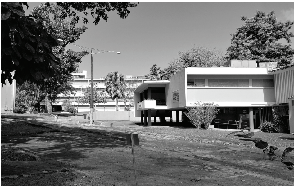
Foto 4. Proximidad y relación con el Edificio de Pedagogía. Servicios Médicos UPRRP. Autor: Carolina Paredes, 2021
