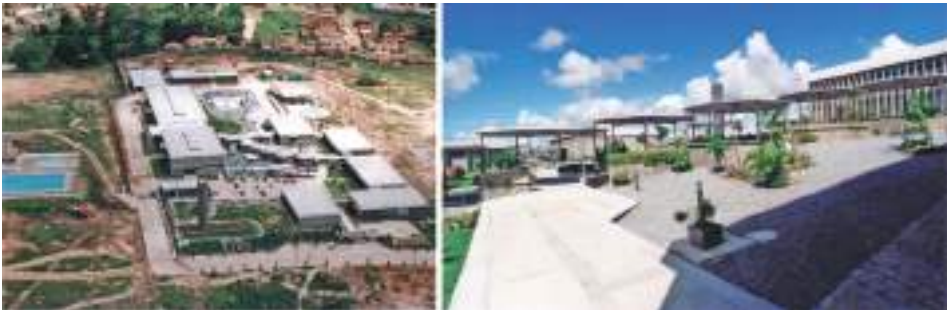
Figura 5. A la izquierda, imagen aérea del conjunto arquitectónico; a la derecha, pasarela cubierta que conecta los edificios
