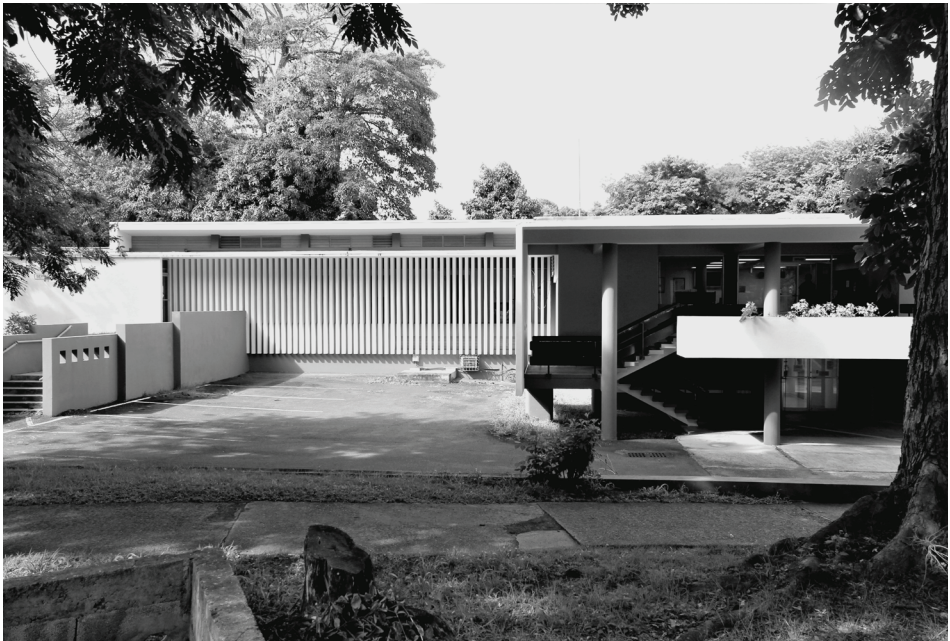
Foto 6. Vista frontal, fachada principal. Servicios Médicos UPRRP. Autor: Andrea Parga, 2017
