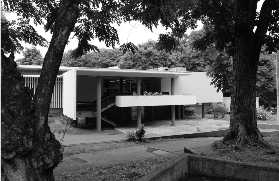
Foto 7. Vista del acceso y la escalera. Servicios Médicos UPRRP. Autor: Andrea Parga, 2017
