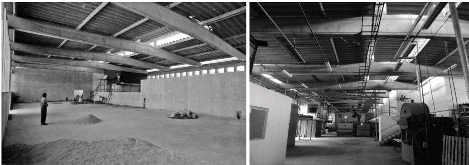
Figura 11. Imagen interna de la nave de producción en proceso de construcción (a la izquierda) y en proceso de uso y ocupación con maquinaria (a la derecha)
