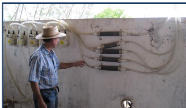
Fig. 3. Instalación de los filtros de viruta y los medidores volumétricos de gas.
