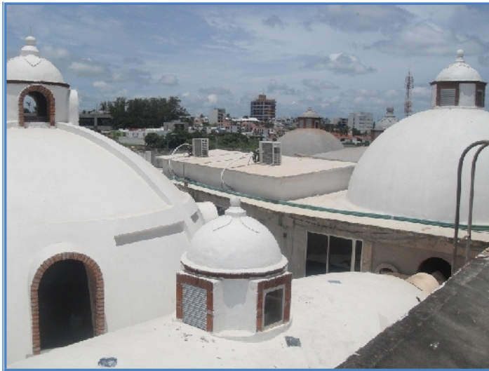
Fig. 6. Rediseño bioclimático del lobby y del hotel, para minimizar la carga térmica del recinto y disminuir el uso de sistemas convencionales de enfriamiento.
