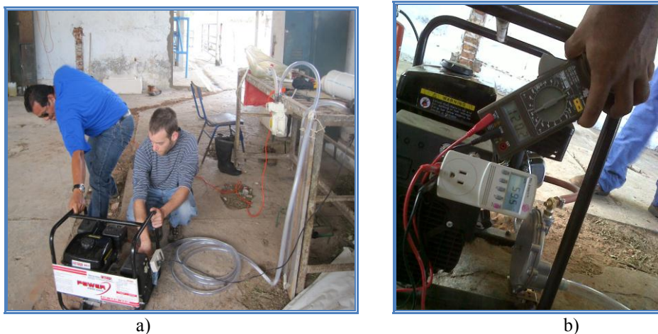
Fig. 5. En la Fig. 5a) se muestra el inicio de la experimentación con el generador eléctrico. En la Fig. 5b) se muestra el Voltaje y la frecuencia de la energía eléctrica producida con el motogenerador.
