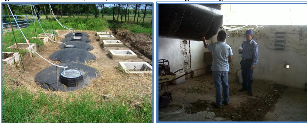
Fig. 1a) se muestran los biodigestores de 5,000 L cada uno utilizados en este proyecto. En la Fig. 1b se muestran los filtros de viruta de hierro, los medidores de gas y la bolsa de polietileno que almacena el biogás.
