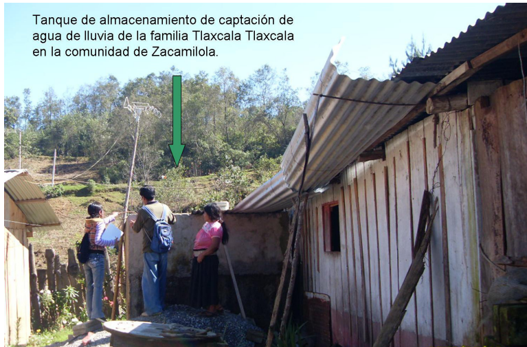
Figura 5: Captación de agua de lluvia a través de los techos de las casas (Foto tomada por el equipo de investigación)
